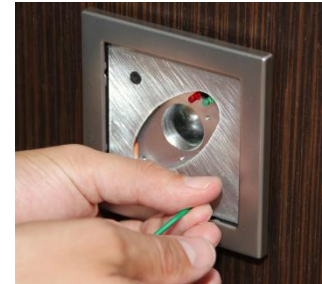
Abbildung 8: Montage der Blende (Schritt 2/3)
