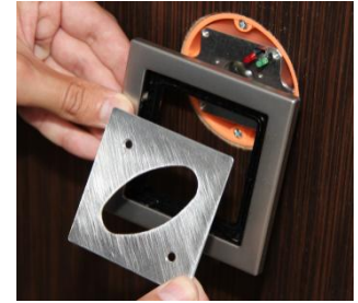
Abbildung 7: Montage der Blende (Schritt 1/3)
