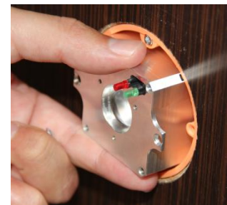
Abbildung 5: Montage des Lesers (Schritt 1/2)
